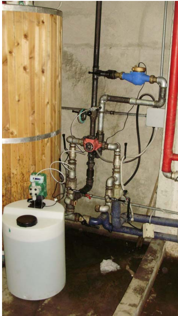
Sistema di dosaggio ANK Anolyte Neutro
