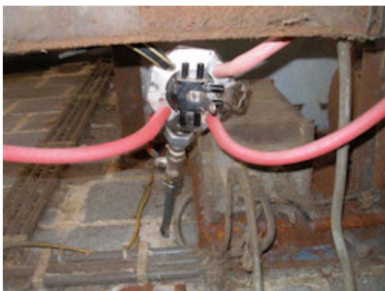
Dal serbatoio, l'Anolyte va, attraverso queste connessioni, alla vasca di lavaggio dello zoccolo
